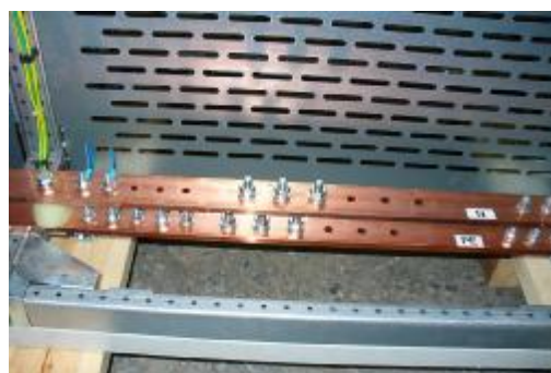
Рис. 5. Нулевая и защитная шины.
